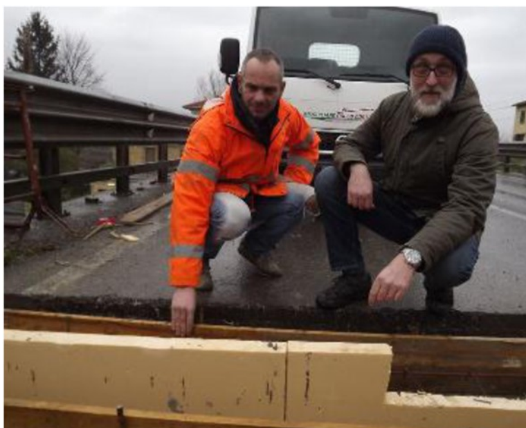
I lavori al ponte di Calcinaia stanno creando disagi ai commercianti (archivio)
