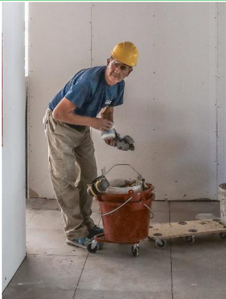
CORSA CONTRO IL TEMPO Lavori ultimati in gran parte degli edifici della Valdera
