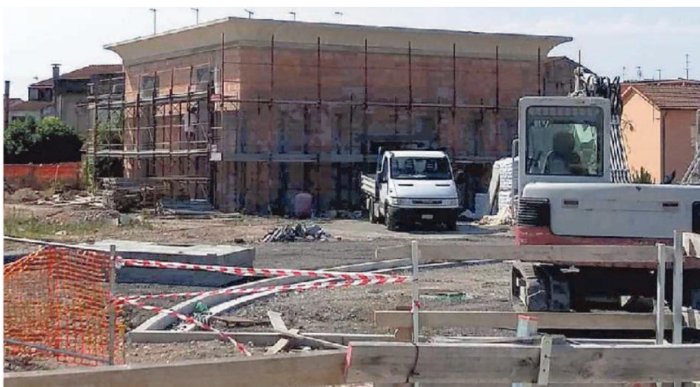
Il cantiere all'interno dell'area del velodromo di Fornacette
