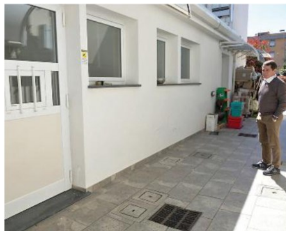
L'ingresso secondario della farmacia che è stato preso di mira dai ladri
