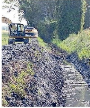
Lavori di pulizia di un fosso
