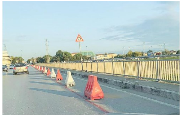
I lavori per la pista ciclabile sul ponte dello Scolmatore
