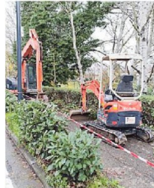
Lavori in via della Botte
