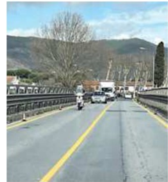
Il ponte a alla Botte sull'Arno: i lavori potrebbero iniziare tra autunno e inverno
