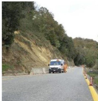
Gli ultimi lavori da parte dei tecnici e degli operai della Provincia di Pisa ieri pomeriggio prima della riapertura della Francesca
